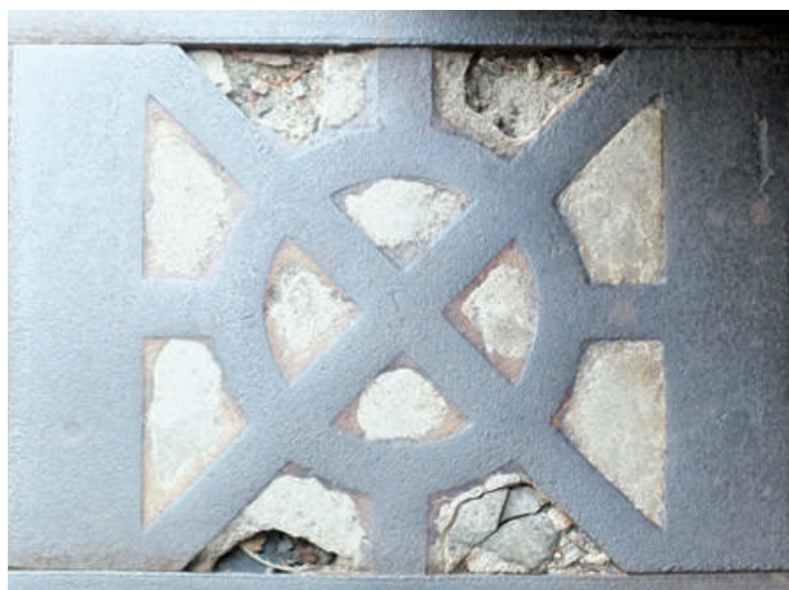
Kovový „kříž“ označující průsečík linií na vstupním prahu kostela sv. Vojtěcha
